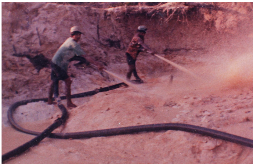
Figura 15: Desmorte do barranco com mangueira bico-jato.
